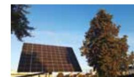
La technologie tracker : le soleil apporte plus d'énergie lorsque ses rayons sont perpendiculaires à la surface. Le tracker fonctionne donc comme un tournesol ! Sa structure portante permet d'orienter les panneaux photovoltaïques vers le soleil en temps réel grâce à deux axes de rotation. L'augmentation de la production électrique par rapport aux panneaux fixes est au minimum de 25 %.
